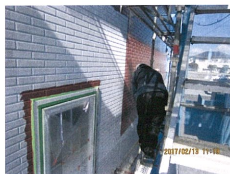
写真 1 外壁塗装の現場及び作業風景
